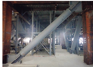
図11 中日ビルに実装された十 字型断面ブレース。
