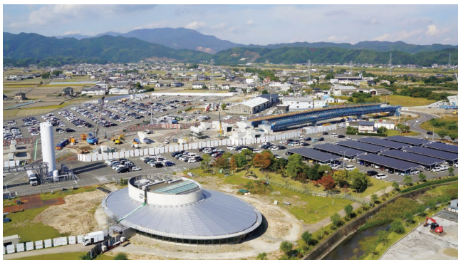
図1 高速道路工事が進む本社工場西側。 (楕円形の建屋は社員食堂，写真右下では新棟を建設中) (オンラインカラー)
